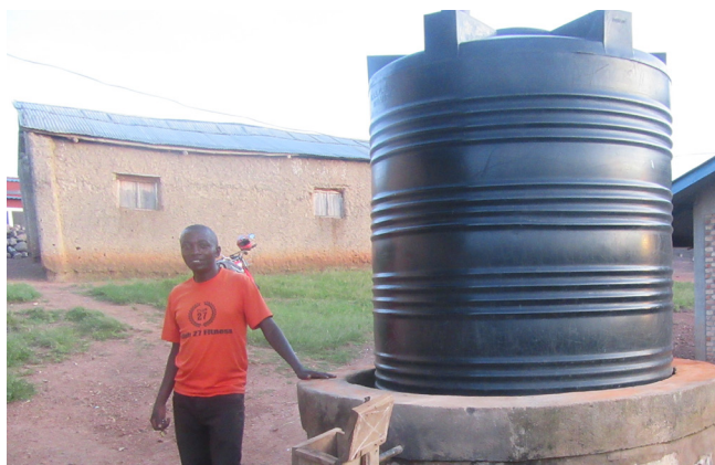
Un des 2 tanks réhabilités.
